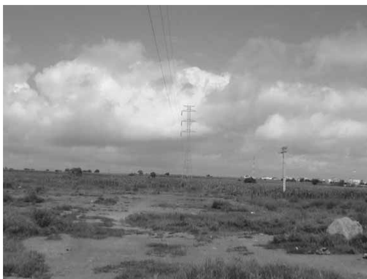
図13 東側から見た、高圧電線が走る計画サイト
