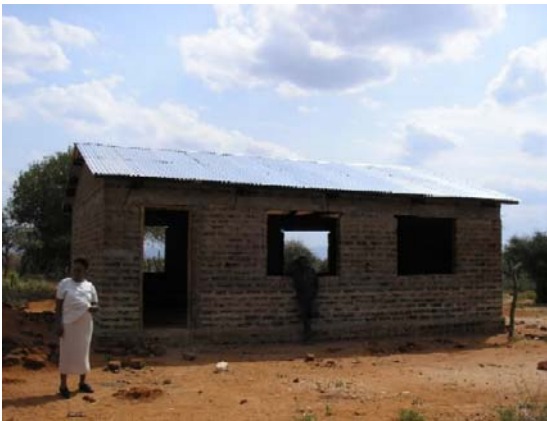
新設する幼稚園校舎（建設中）
