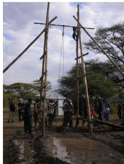
4本目掘削現場
