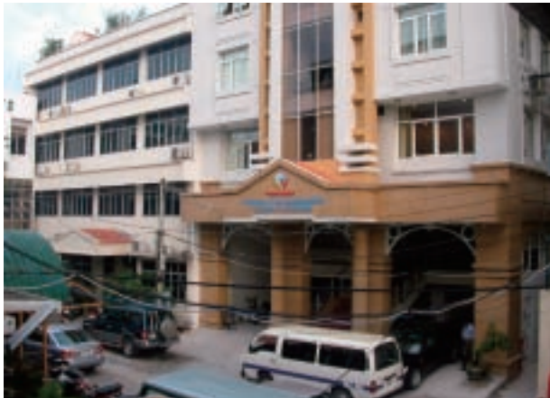
写真1 植物防疫局植物検疫第2支局 第2隔離検疫センター(ホーチミン市)
