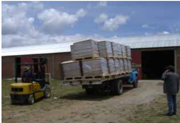
写真3. 中央センター (民間借用倉庫) の現況： 倉庫床レベルは地盤面とほぼ同じため、入出荷作業の 障害となっている。
