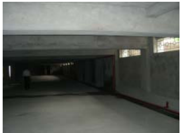
地下1階 [駐車、駐輪予定] (工事はほぼ完了)
