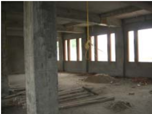
3階 [BSL-3 実験室予定] (日本国側工事待ち)
