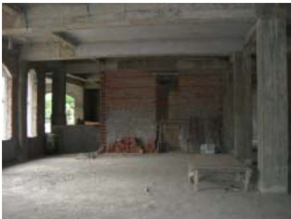
1階 [「べ」実験室予定] (「べ」国側計画の間仕切施工中)
