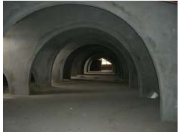
4階 [小屋裏部分、設備機械設置予定] (変更設計待ちのため工事を止めている)
