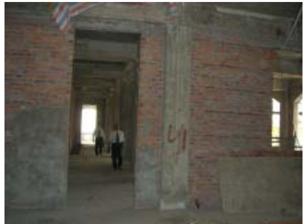
2階 [「べ」実験室予定] (「べ」国側計画の間仕切施工中)
