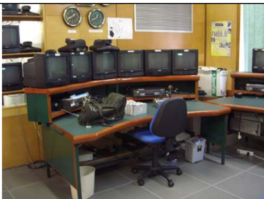
機材の更新が必要な USPNet コントロール室
