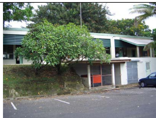
既存自家発電気室・受電室
