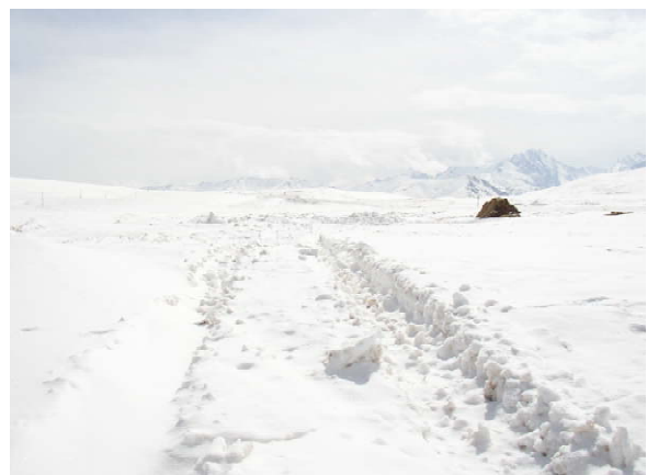
対象道路480km付近の積雪状況: 路肩に積った40cm程度の雪。本線の積雪は10cm程度で、今年には積雪が少ない(通常は路肩で150cm程度の積雪)。
