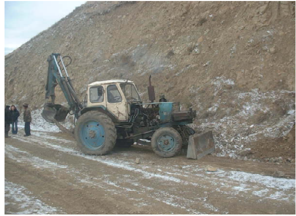
降雪期を前にドロン峠(283km)の車幅を確保するための道路維持管理作業(路肩整理)を行う第955道路維持管理事務所の作業員
