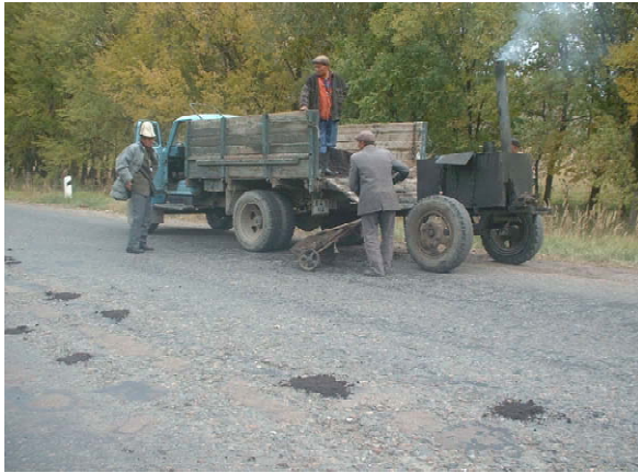
対象道路220km付近の道路維持管理作業(ポットホール修繕: 常温アスファルト材を加熱して補修部に置く)を行う第955道路維持管理事務所の作業員
