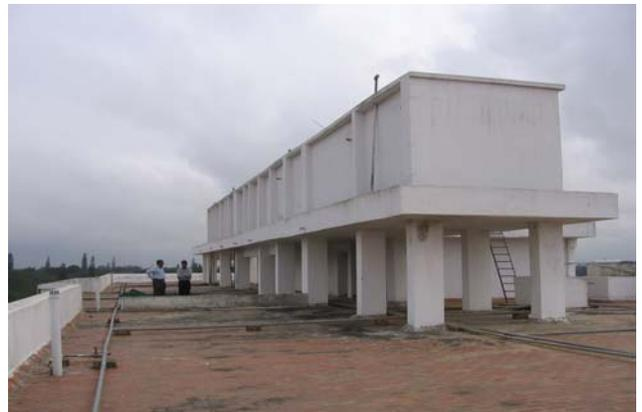
写真 14 : IGICH の高架水槽（屋上に設置）
