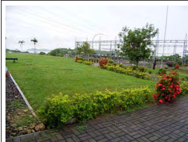
PT. MAKASSAR POWER (構内及び開閉所)
