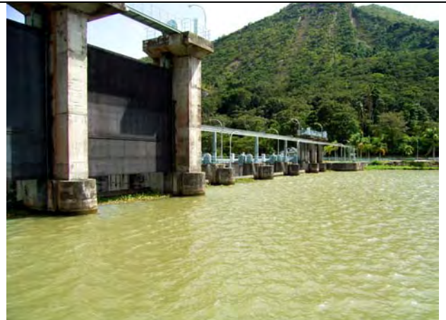
バカル水力発電所排砂ゲート
