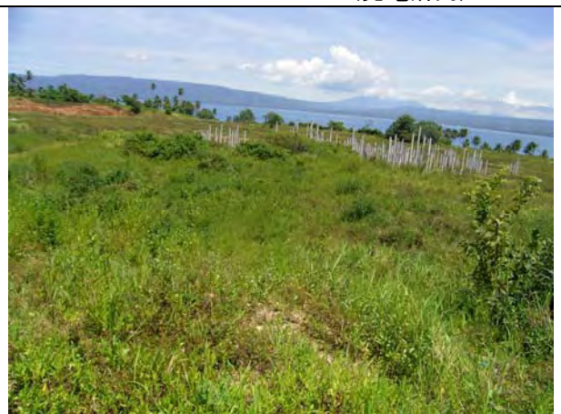
IPP-Amurang 石炭火力建設予定地 (基礎杭打込み済み)
