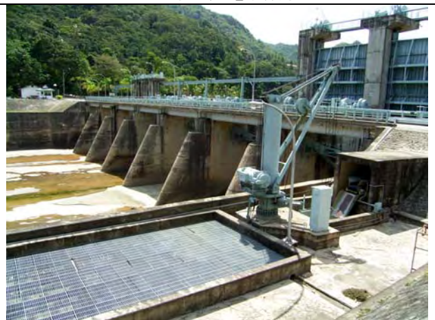
バカル水力発電所堤体下流面
