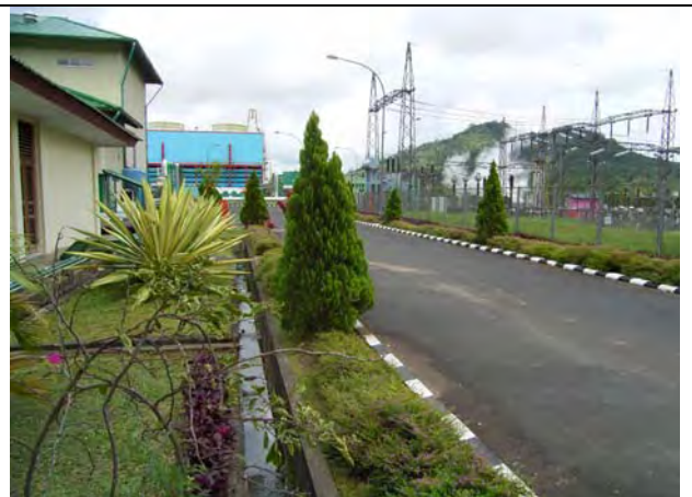
ラヘンドン地熱発電所構内
