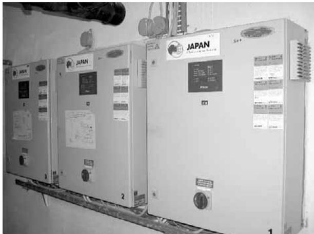
1998年に設置されたドイツ製の紫外線照射殺菌装置。主として種苗生産施設に飼育水を供給している。フィルター部細菌数もルーチン業務として検査されているなど、しっかりと管理体制が確立され、メンテナンスも良好であると判断された。紫外線ランプは16個使用しており、通常8000時間照射で交換が必要となるが、トラブゾン中央水産研究所では種苗生産開始前に交換されるとのこと。スペアランプの価格は600ドル/個でドイツからトルコ業者が輸入している。なおランプ交換にかかる費用はトルコ側負担。
