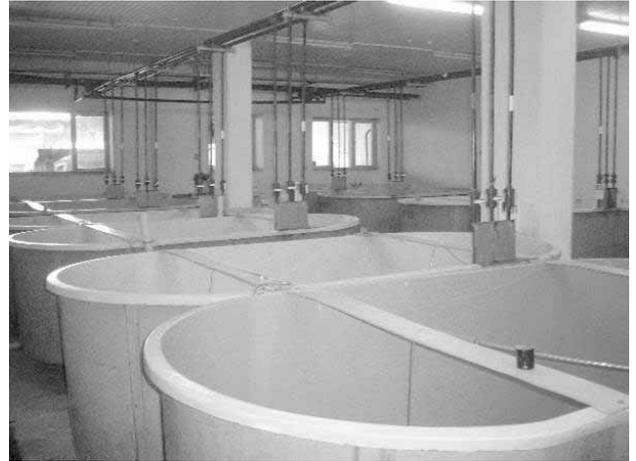
トラブゾン中央水産研究所における種苗生産施設。左の写真は種苗生産用タンク（20L タンク×36 個）で孵化後の初期に使用されている。一方、右の写真は種苗生産用タンク（2.5 トン）。飼育に使用される海水は紫外線殺菌されたものが用いられている。
