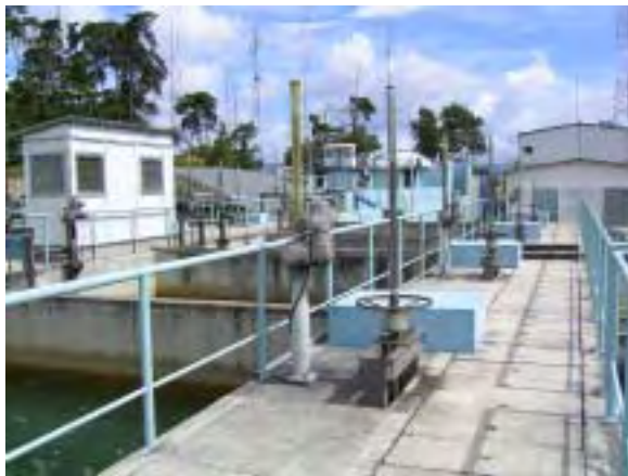
Planta de Tratamiento Picacho
