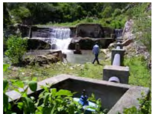
Presa Derivadora en el Río Sabacuante y Tubería de Conducción
