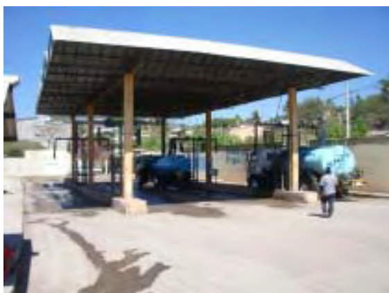
Estación de Llenado (para camiones privados)
