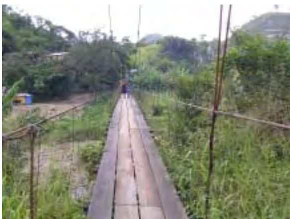
Puente Colgante, Aguas Arriba de la Presa Los Laureles II
