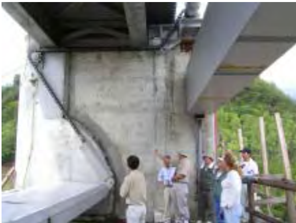
Presa Concepción: Obras de Instalaciones en la Compuerta del Vertedero
