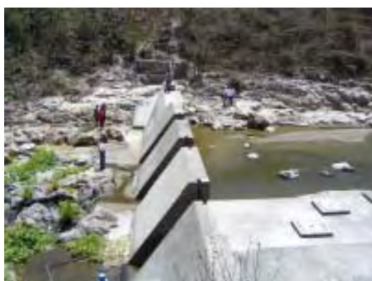
Presa Derivadora Ojojona
