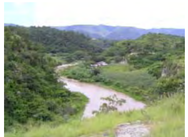
Sitio de la Presa Los Laureles II, desde Margen Izquierda, Aguas Arriba
