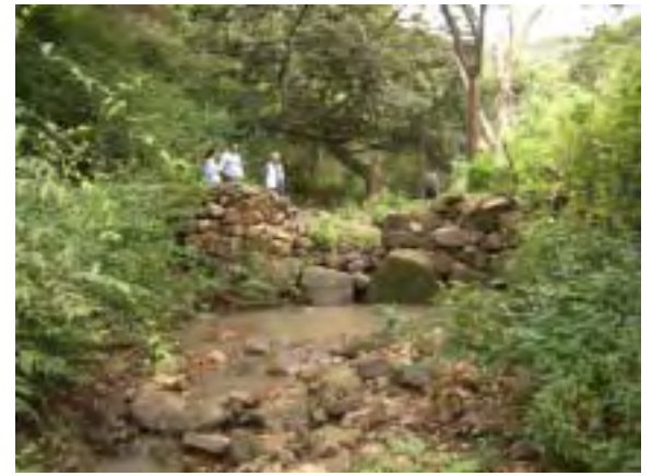
Presa Sabo Existente en Concepción
