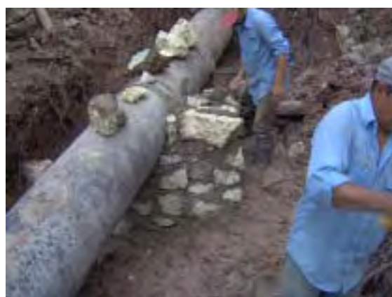
Reparación en Tubería de Conducción (proporcionada por SANAA)
