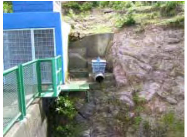
Presa Concepción: Tubería de Conducción del Río Próximo hacia el Embalse
