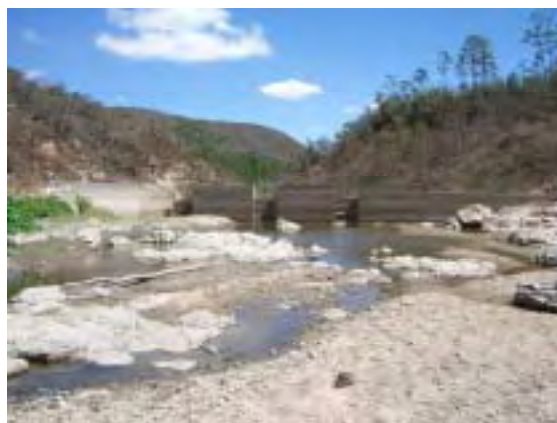
Presa Derivadora de Ojojona (desde Aguas Arriba)
