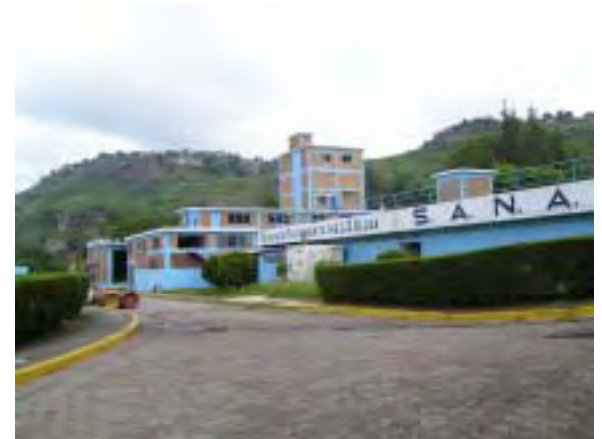
Planta de Tratamiento Los Laureles
