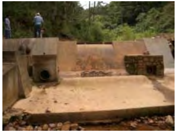
Fuente de Agua de El Picacho
