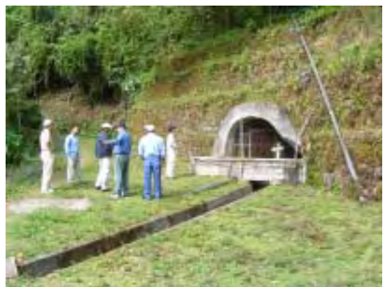
Túnel de Captación Rosario (Picacho)
