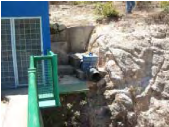
Descarga de la Tubería de la Derivación de Ojojona al Embalse de Concepción
