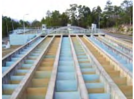
Planta de Tratamiento Picacho (tanque de mezclado)
