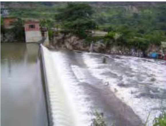
Compuerta de Hule del Vertedero
