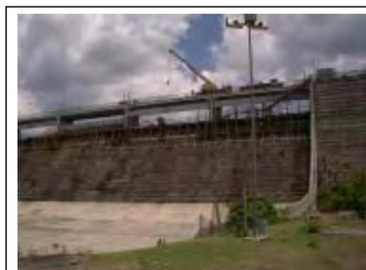
Concepcion ダム洪水吐に建設中の鋼製自動転倒ゲート
