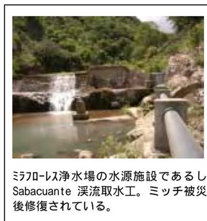
ミラフローレス浄水場の水源地であるし Sabacuante 溪流取水工。ミッチ被災後修復されている。
