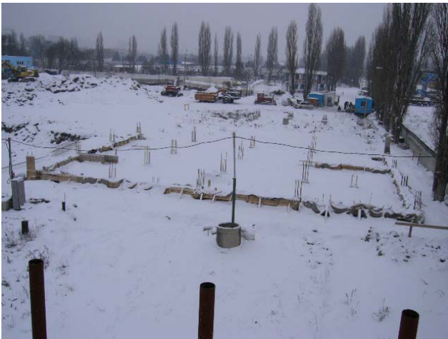
2006年2月10日現在。建物の下部の型枠作業を行ったところ。
