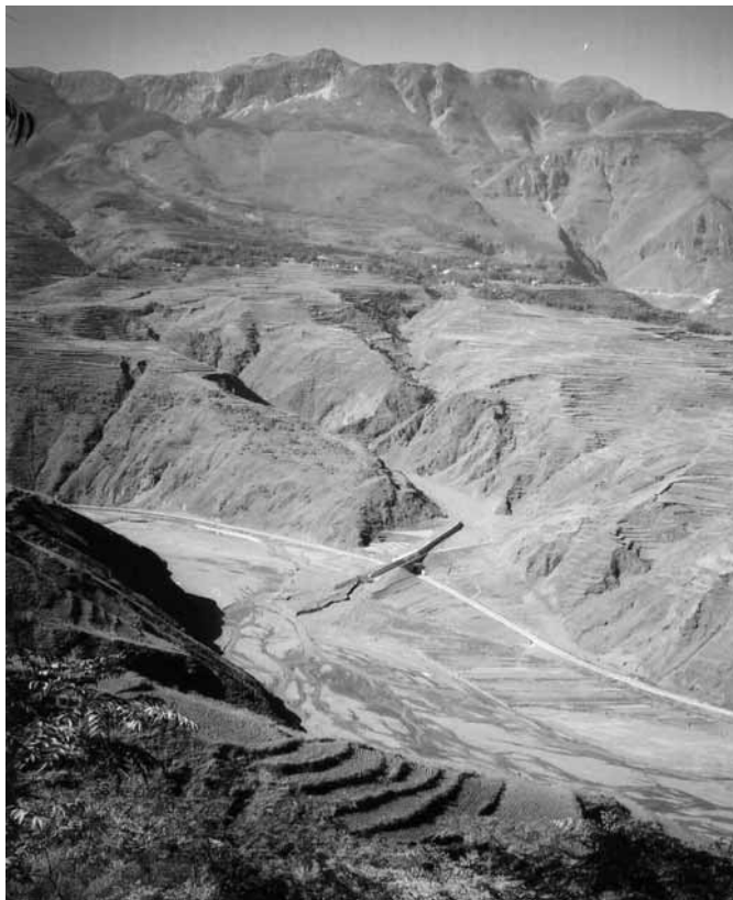
写真-4：鉄道線路及び流路工（左支川）交差箇所（大白河左岸）
