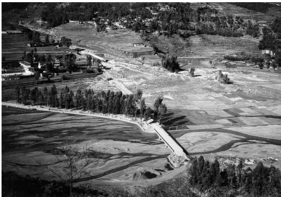
写真－16：阿旺郷付近の大白河の河道（橋により狭くなっている）
