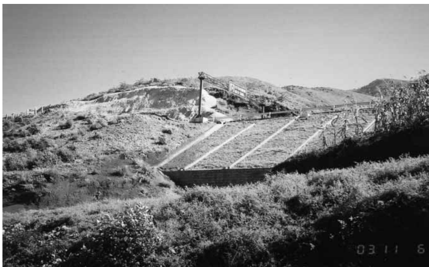
写真－2：完成した高速道路の盛土法面縦排水溝及び切土法面セメント吹付工
