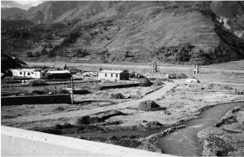
写真-3：施工中の橋脚、桃家小河河床状況（養魚池、骨材採取）、大白河左岸の状況
