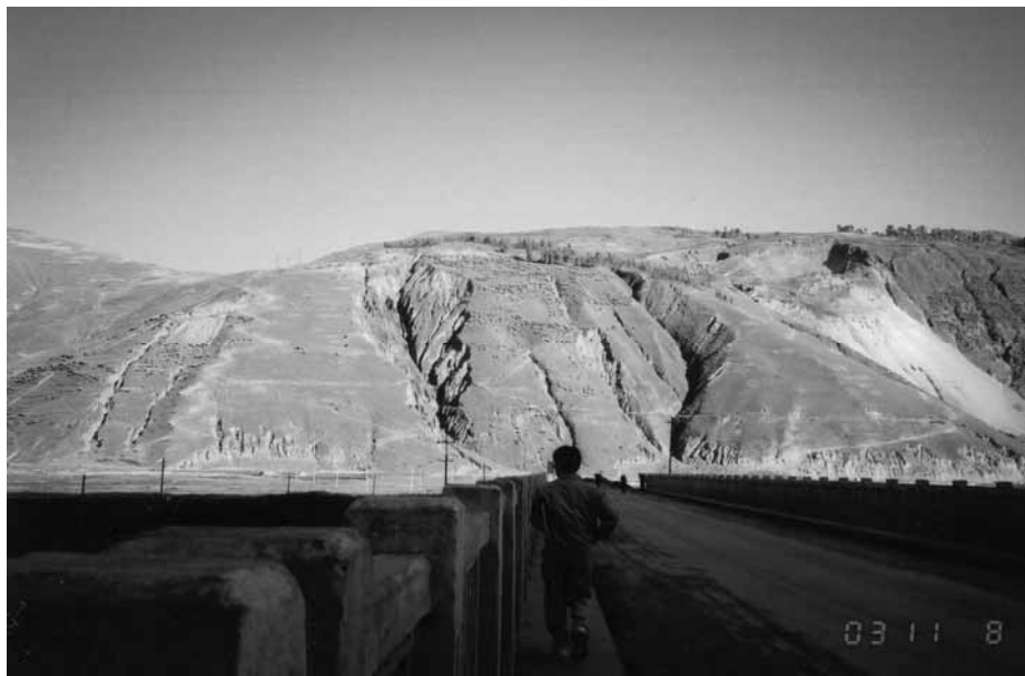
写真－13：小江橋及び小江右岸側山腹のガリ侵食
