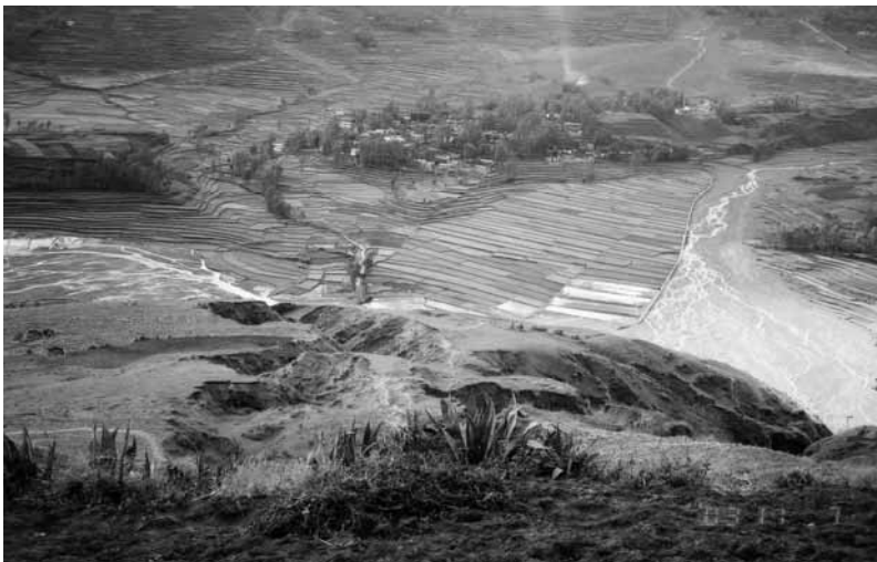
写真－7（上）：烏龍河河道状況及びガリ（手前）発達状況
