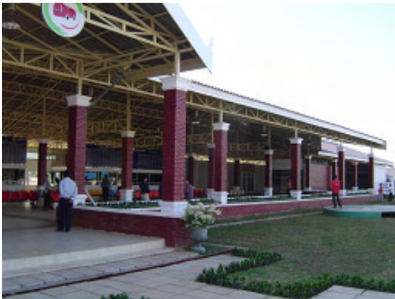
新設長距離ターミナル(外観)
