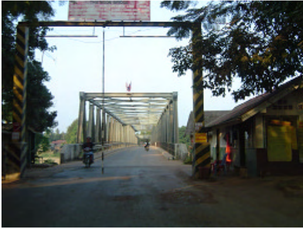
市街地北方 10 号線の橋梁(有料)。
