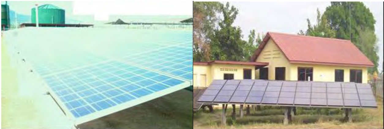
(a) 大型 PV (50 kWp) & Biogas ハイブリッドシステム (b) 大型 PV (30 kWp) & MH ハイブリッドシステム 図 5.3.3 NEDO/MIME 共同実証実験プロジェクト
