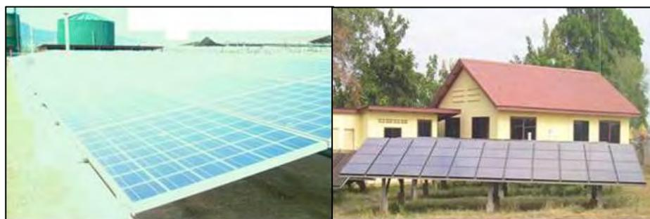
(a) 大型 PV (50kWp) とバイオガスのハイブリッドシステム (b) 大型 PV (30kWp) & 小水力とのハイブリッド
