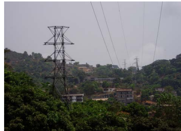
キングトムからの33 kV送電線(左)と ブンブナ水力方向への161 kV送電線(右)
