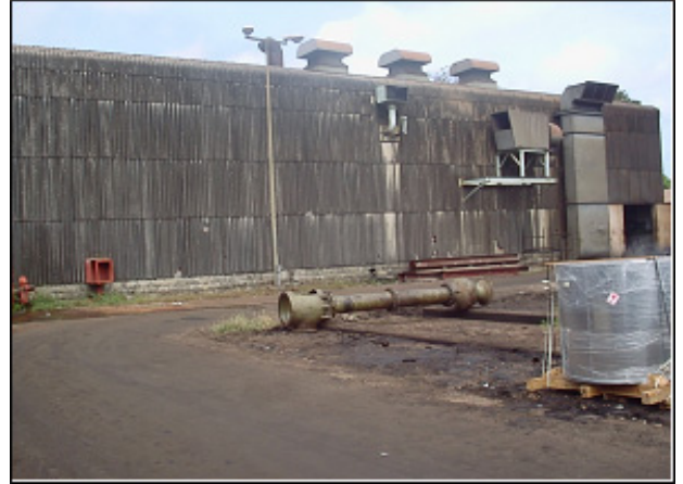
三菱重工製DEG発電機(5MW)建屋
