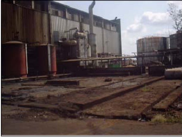
キングトム発電所:5MWx2台DEG設置 予定地
