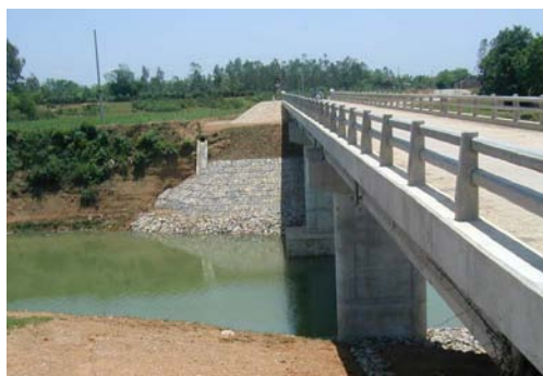
コンクリート製高欄
