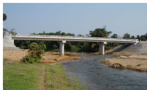
完成した施設建設型 6 橋の 1 つ
