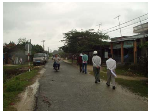
左岸接続道路 : 3.5m で舗装済
