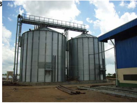
流通等：Pontianak 市に建設中のアグロビジネスセンターに完成した 2 棟の穀物サイロと 1 棟の多目的倉庫(右)。配合飼料製造の計画もある。
