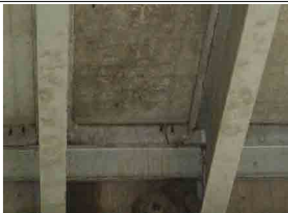
写真-17 腐食している主桁フランジ
