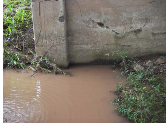
写真-22 左岸側橋脚のひび割れ及び洗掘
