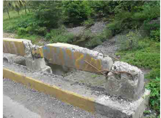
写真-2 車両衝突による高欄の損傷
