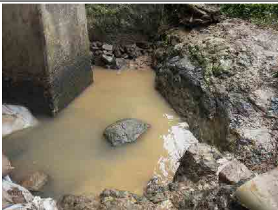
写真-23 右岸側橋脚の大規模な洗掘
