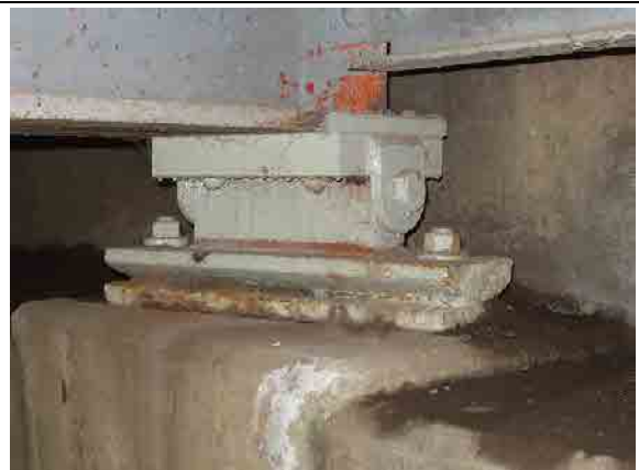
写真-24 腐食により機能不全となった支承
