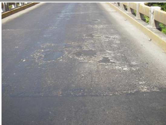
写真-5 損傷の著しい床版上面
