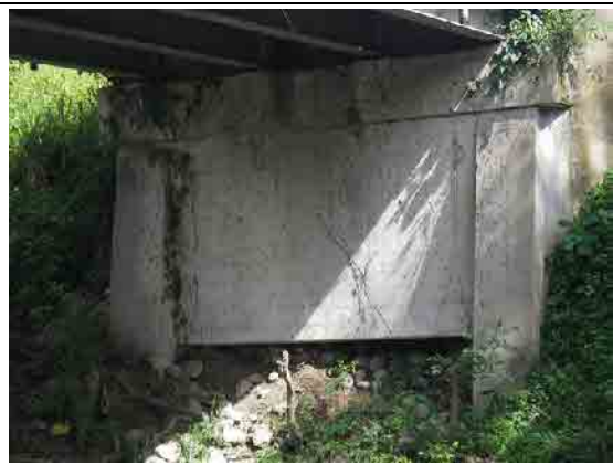
写真-18 護岸崩壊により裏込めが崩れた橋台
