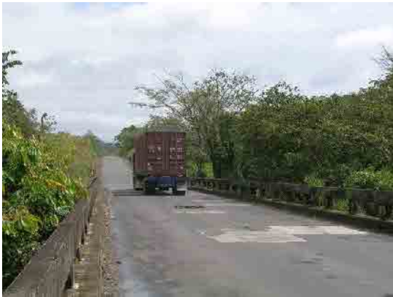
写真-9 床版欠損部を跨いで走行する大型トレーラーの危険な走行状態
