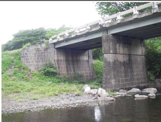
写真-3 耐震性に劣る石積み橋台・橋脚
