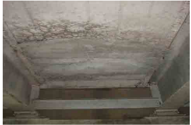
写真-8 補修後進行するコンクリート床版のひび割れ
