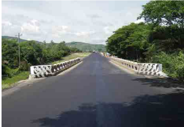
写真-1 前後の道路部分に比べて狭い橋幅員
