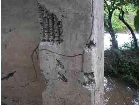
写真-21 施工不良による左岸側橋脚の断面崩壊
