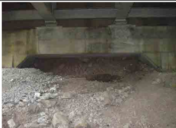
写真-11 護岸崩壊により裏込が崩れた橋台
