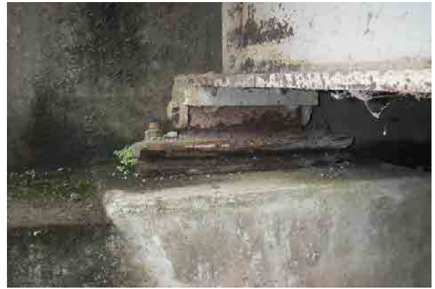
写真-10 腐食により機能不全となった支承
