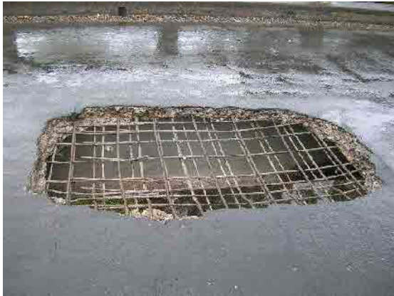
写真-7 床版の欠損部
