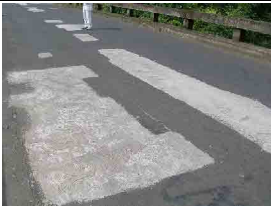
写真-15 床版の補修跡
