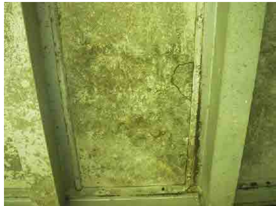
写真-14 床版下面のひび割れ
