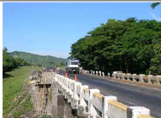
写真-6 高欄損傷箇所の補修作業
