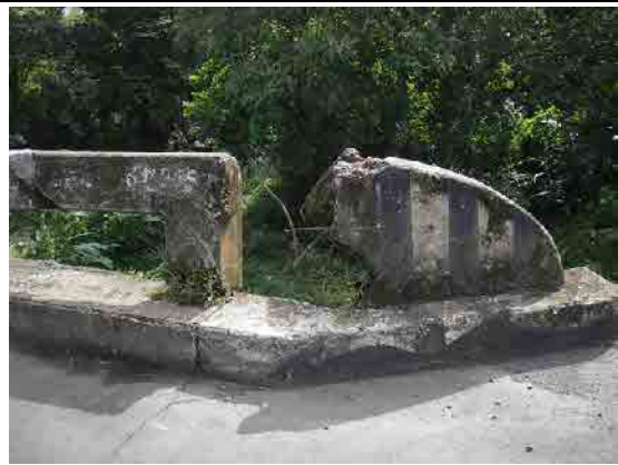
写真-16 車両衝突により損壊した高欄
