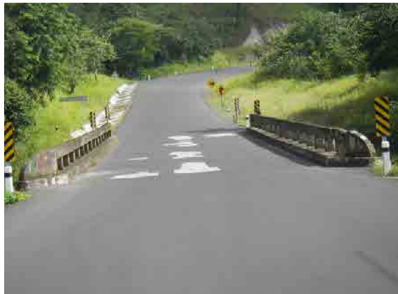
写真-13 欠損により補修を重ねるコンクリート床版表面
