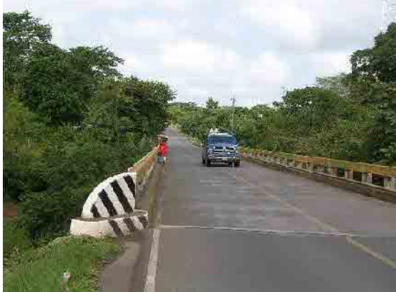
写真-19 歩行者が危険を感じる狭幅員。 車両は歩行者を避けるため対向車線を走行。
