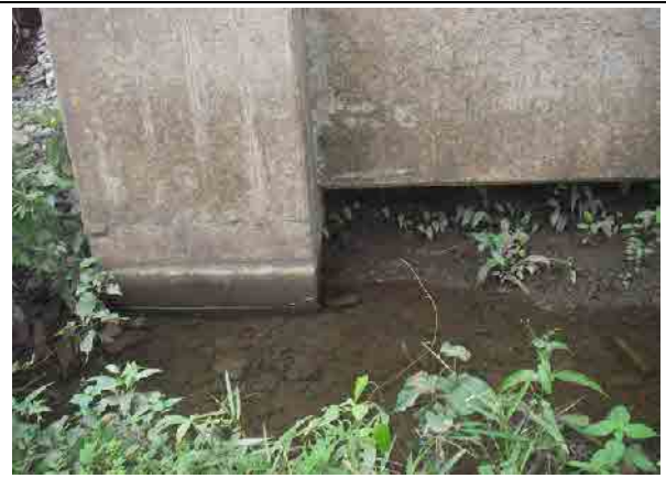
写真-12 洗掘及び橋脚のひびわれ
