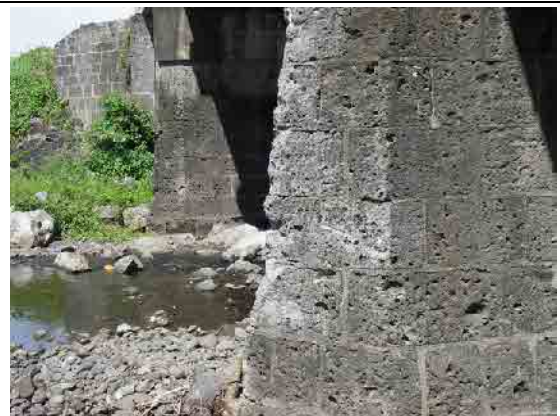
写真-4 流木の衝突で損壊した橋脚
