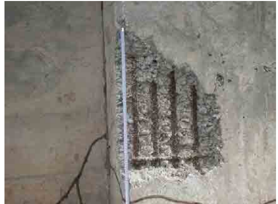
写真-20 施工不良による左岸側橋脚の断面崩壊
