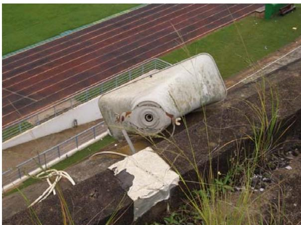
メインスタンドの建屋の屋上に設置された既存スピーカー。破損している。
