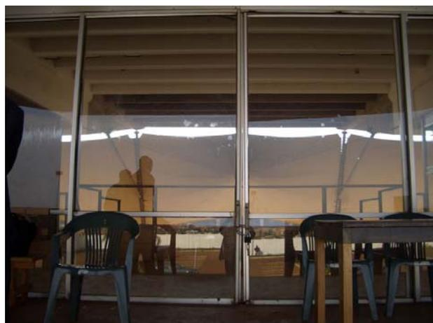
メインスタンド側の玄関サッシ。開閉が困難なうえ、適切な施錠ができない。撮影後、3月の強風で2枚が破損。
