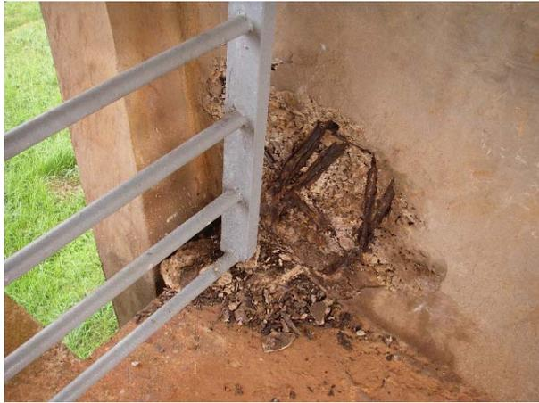
鉄筋の露出箇所。錆が顕著である。
