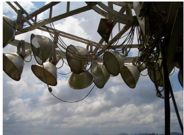
既存照明塔の状況。点検は専用のモータを使用し、照明機部分を昇降させて行う。今回の協力対象外。
