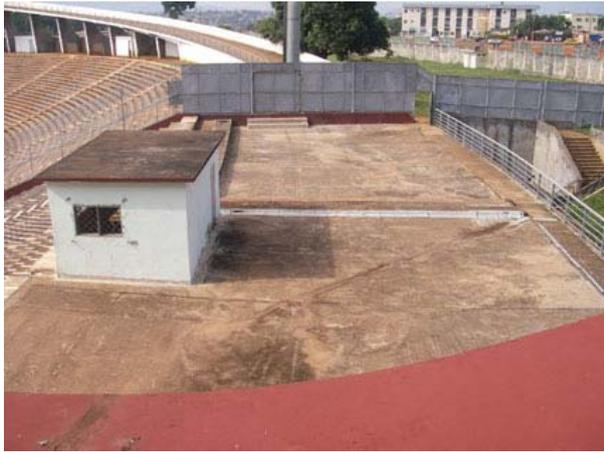
地下階事務室の屋根。中央に排水溝が見える。外観から漏水箇所は特定できない。
