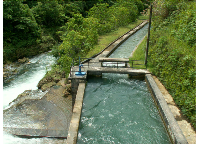
(2) 取水口の状況 (ほぼ満水状態で取水している)
