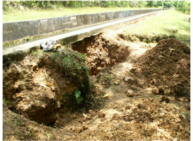
(8) クラック掘り起こし作業終了分
