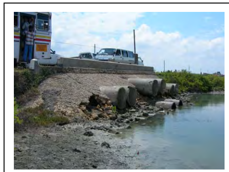
爆発後改修されたカルバート
