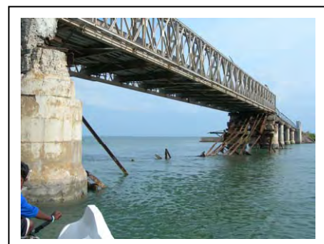
中央径間に架かるベアリー橋
