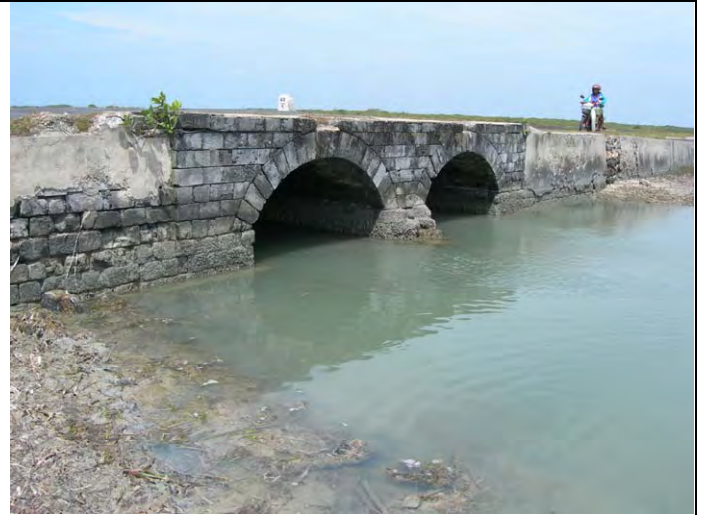
コースウェイを横断する石積みカルバート。1930 年 当時に建設されたと思われるカルバート。
