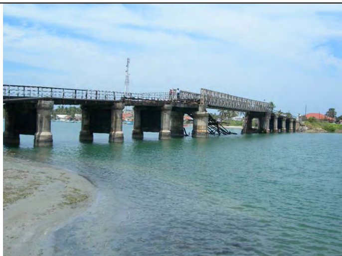
マナー橋の全貌。全長 121.2m、幅員 4.2m、9 径間で、中央径間は爆破されベアリー橋が架けてある。
