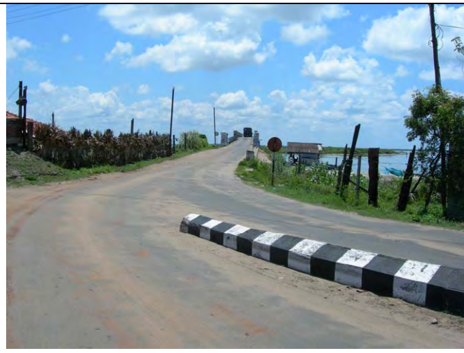
マナー島側の橋梁取付け道路。急カーブになっているため、事故防止用の導流帯が設けられている。
