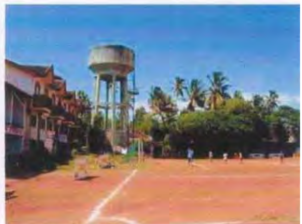
市内の高架水槽
