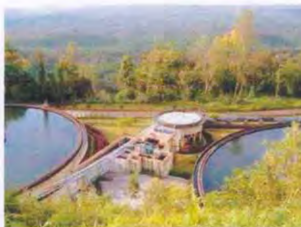
既設 160MLD Salaulim 給水システム エアレーター & 凝集沈殿池
