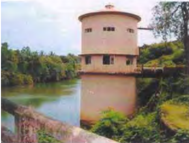
Opa 浄水場 取水塔 (Jack Well)
