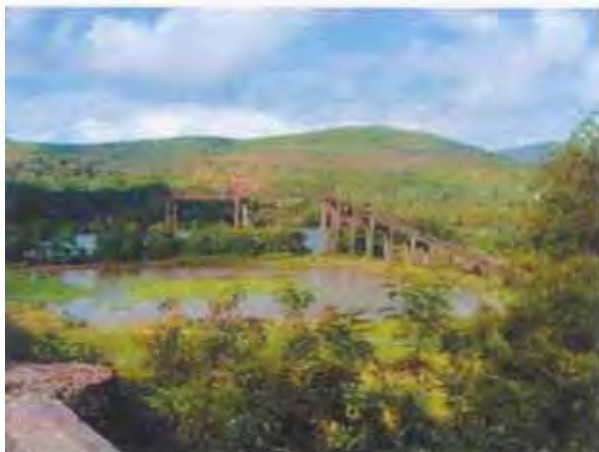
220MLD Salaulim 増強給水システム Ponda への河川横断部(既設橋梁を利用)
