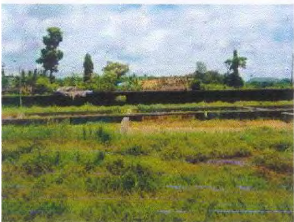
Margao 市 既存下水処理場の汚泥乾燥床 流入量が少ないため未利用
