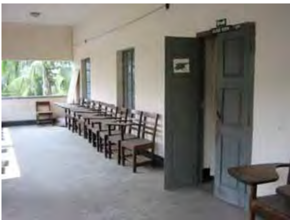
NAPE 3 階の JICA 専門家（コンサルタント）執務予定室の外観
