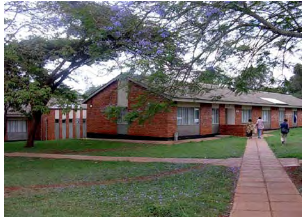
宿泊棟-A棟外観。平屋建て、ツインルーム23室
