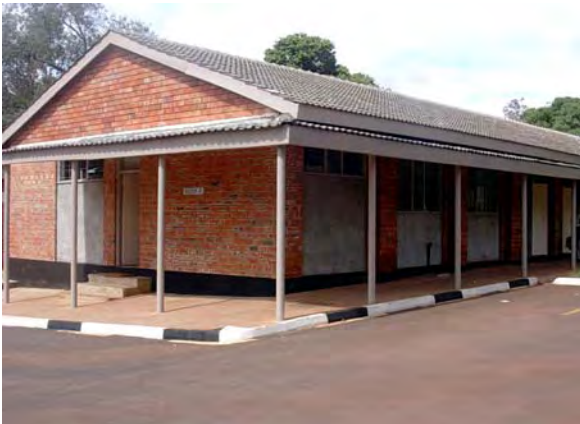
教室棟-E外観。化学、生物教室がある
