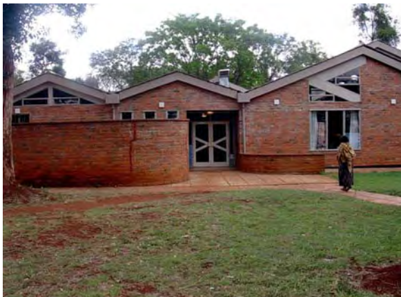
食堂棟外観。右手が食堂
