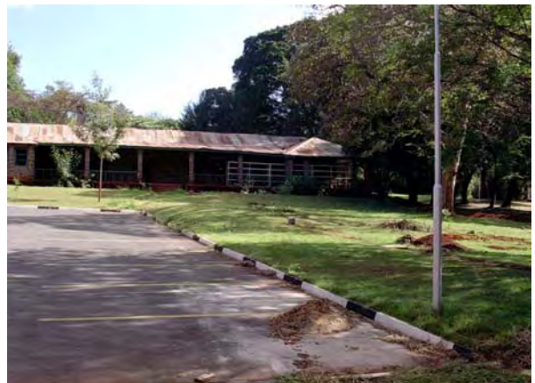
研修棟建設用地。前方は事務棟
