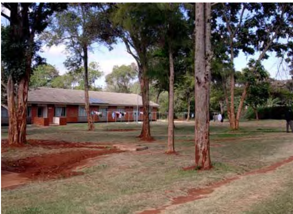
新宿泊棟建設用地。左手は既存宿泊棟
