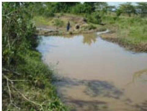
アワチ川ゲム - ラエ分水工 (Samez 報告書より)
