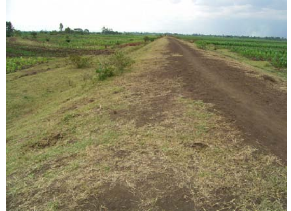
アヘ口橋下流部左岸堤防（コントラ
