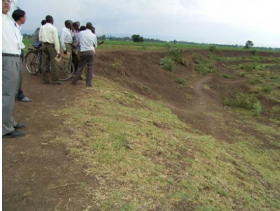
アヘ口橋下流部左岸堤防（直営区間）
