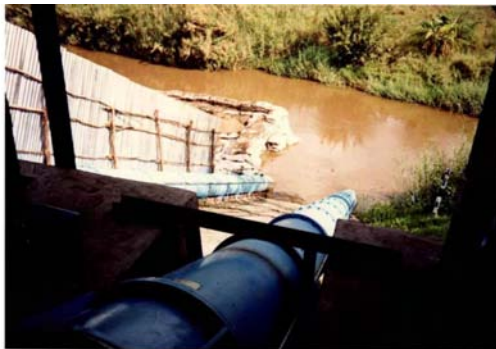
アヘロ・パイロット事業ポンプ場 (左側・ポンプ改修中)
