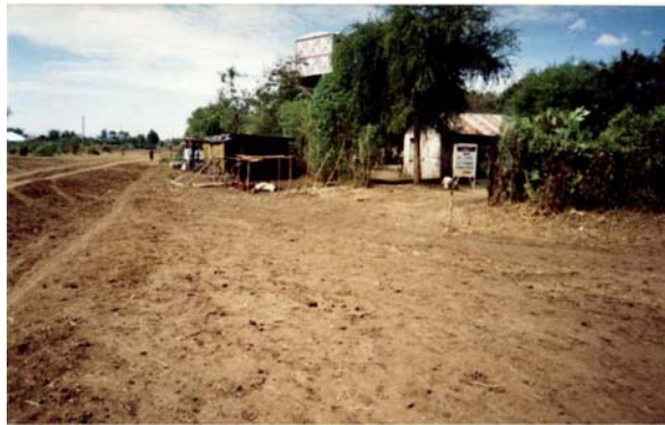
中学校(右奥)の給水タンク(井戸から揚水する)
