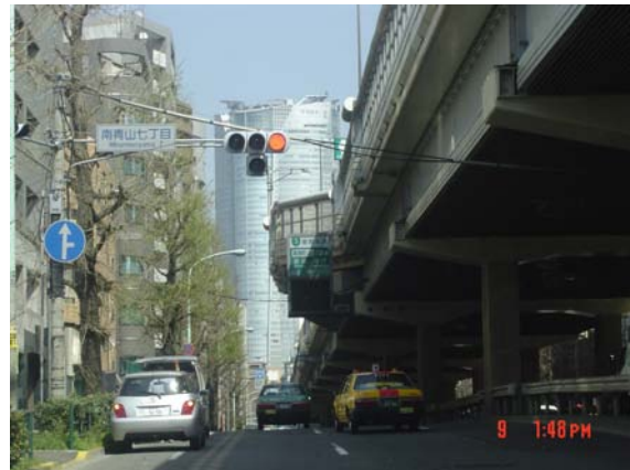
非常駐車・電話スペース 首都高速道路
