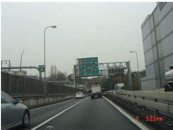
可変案内標識 首都高速道路
