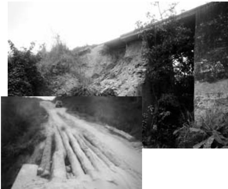
クアンザスル州 CONDA 郡 Huande 村付近 Bule 川を跨ぐ橋梁（CONDA 郡内の幹線道路）
