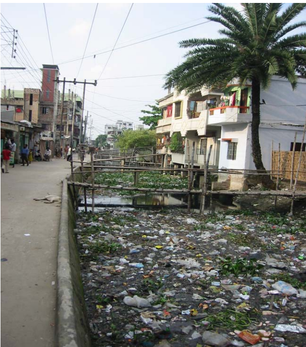
9. セグンバギチャ排水路（カマラプール道路から約1.0 km付近）
