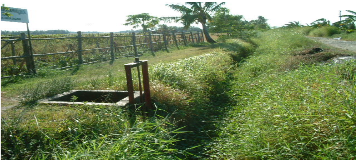
水路への堆砂（アガナン・サンタバーバラ国営灌漑システム）
