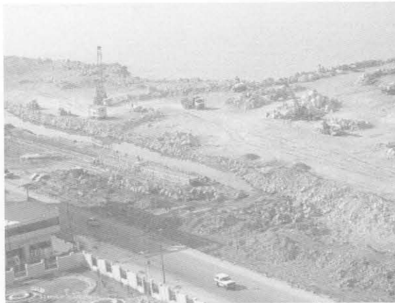
タルトゥース市インターセプター工事中
