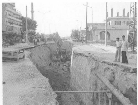
ディエルゾール市下水幹線管工事
