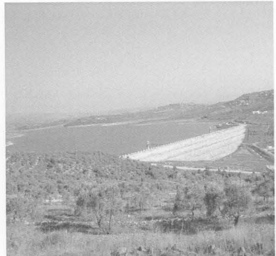
Basselダム 15ヶ所から下水が流入。 水道水には使っていない。灌漑用水のみ
