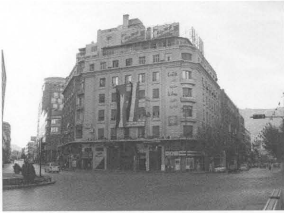
住宅建設省正面（2階以上が事務所） ラマダンの金曜日で人通りは少ない
