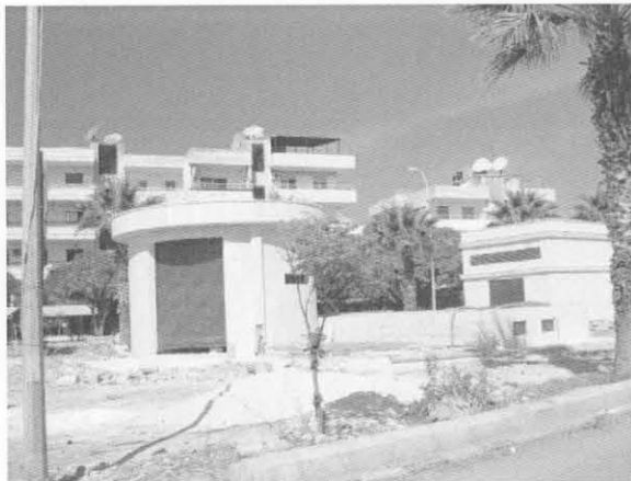
土木工事が完成している下水ポンプ場 機械設備設置の時期は未定
