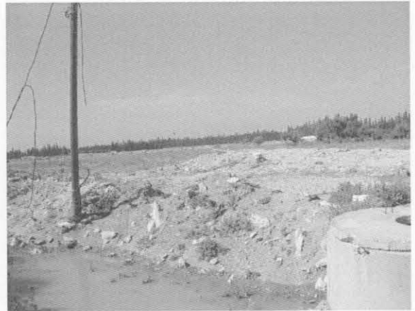
ラタキア市下水処理場建設予定地 元は果樹園（伐採済み）。遠くの樹木が境界
