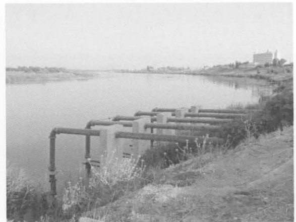
ディエルゾール市のユーフラテス川からの 上水道の取水管
