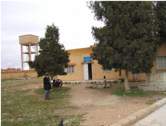
施設の外観 1階平屋建て。
