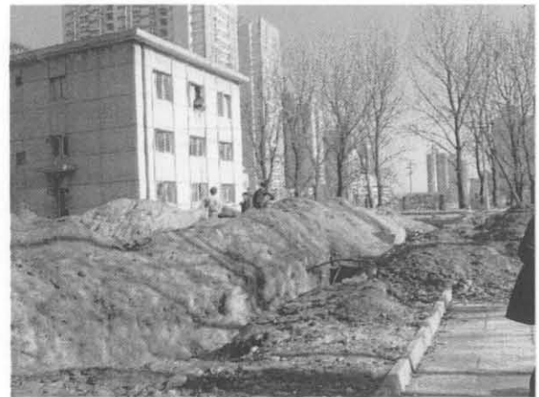
性能評価試験装置の実験室の建設現場
