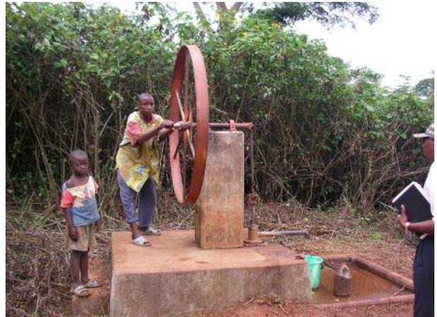
BID プロジェクトで 2002 年に建設されたポンプ付き深井戸、稼働中であるが、排水設備がないため汚水化している。India MK II ポンプ（南部州 Meyo Nkoulou 村）
