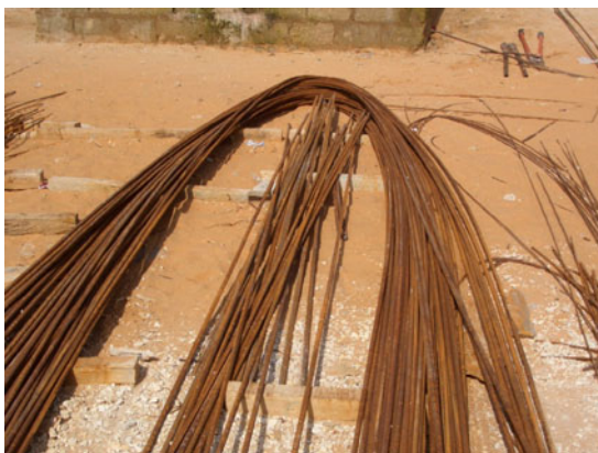
輸入鉄筋（2階建校舎用） 地面に直接置かず木片の上に保管
