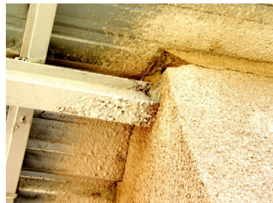
折板屋根が不揃い 小屋組用鉄骨の塗装工事不備
