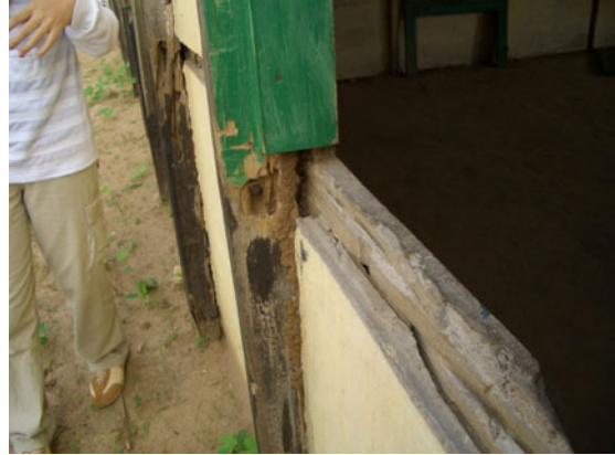
木の柱とパネル固定の木の枠がシロアリに浸食されている 竹で補強されたモルタル壁
