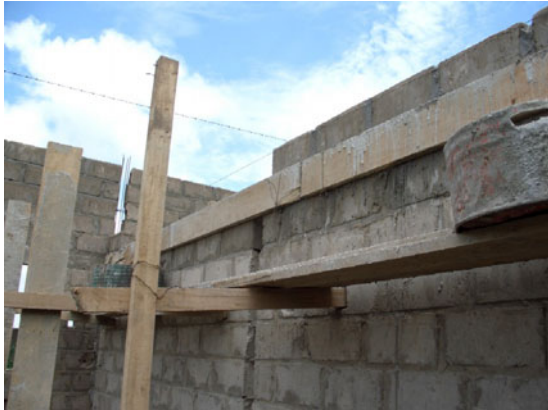
内壁補強小梁型枠 針金で固定
