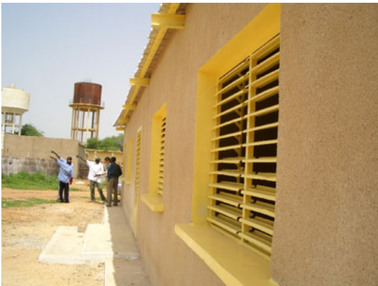
折板屋根が不揃い 小屋組用鉄骨の塗装工事不備
