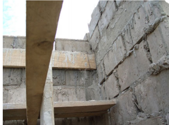
内壁補強小梁型枠 木板の下部にスラリーが垂れている
