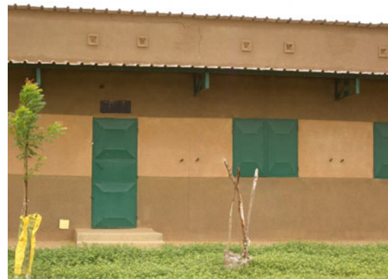
アルミ庇が足場とならない為、庇上の壁左官工事が施工不良となった
