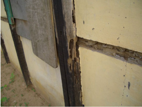
木の柱とパネル固定の木の枠がシロアリに浸食されている 竹で補強されたモルタル壁
