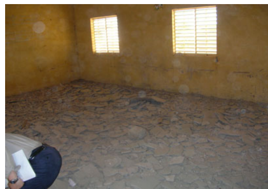
床の前面修理中
