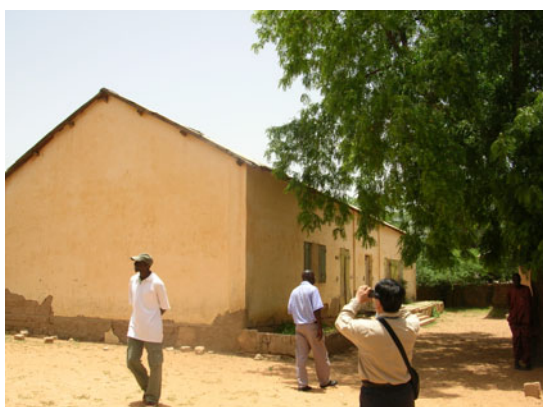
既存敷地の老朽教室（1947年）
