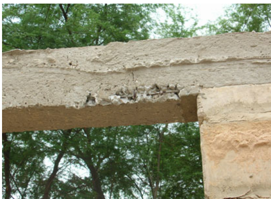
建設中の BCI 教室
