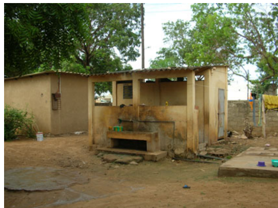
トイレは使用可能
