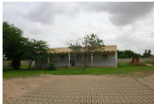
敷地内でコンクリートブロックを製造中
