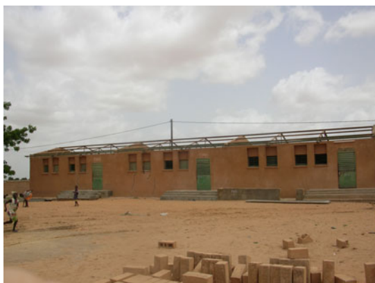
屋根を修理中の教室
