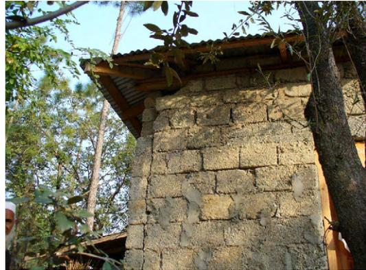
写真 28 壁隅角部のひび割れと上部ブロッ
