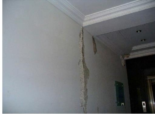
写真 36 事務所ビル 1 階柱とブロック壁の間のひび割れ
