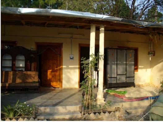
写真 25 ブロック造壁構造住宅
