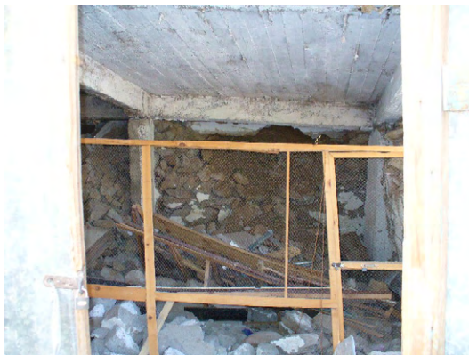
写真 9 写真 8 の建物の 1 階内部
