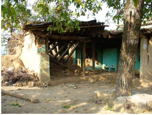
写真 21 石造壁住宅 2 正面
