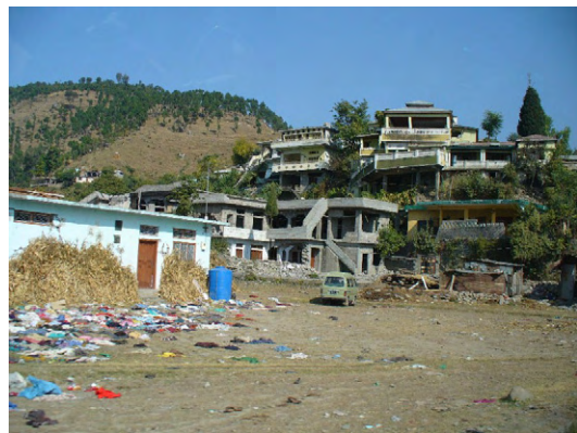
写真 10 バラコットの南約 5km にある鉄筋コンクリート造と思われる建物
