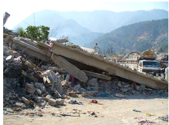
写真 4 バラコットのクナル川東側にある 鉄筋コンクリート造のホテル
