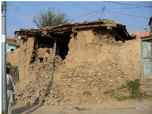
写真 19 石造壁住宅正面
