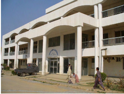
写真 11 州立マンセラ病院本館
