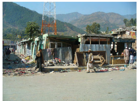
写真 6 バラコットの中心街と思われる商店街のうち一部(写真の左奥)が倒壊を免れている(クナル川西側)
