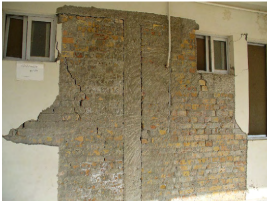
写真 13 病院本館 1 階の柱とレンガ造壁
