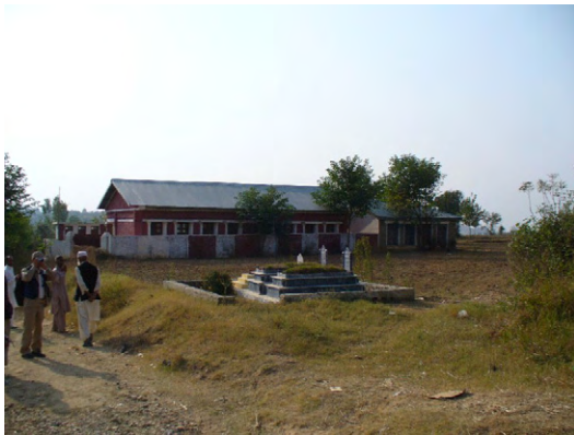
写真 23 州立女子小学校 2 棟(左が RC 造、 右がブロック造)
