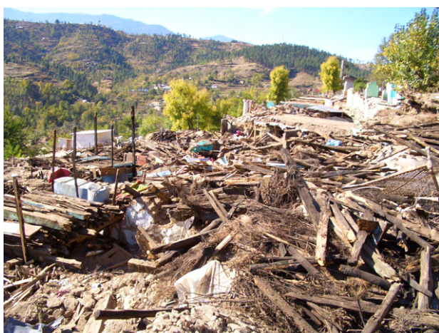
村落崩壊の様子
