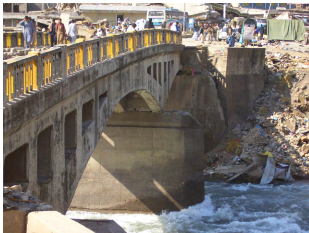
橋の拡大 (南へ1mずれている)
