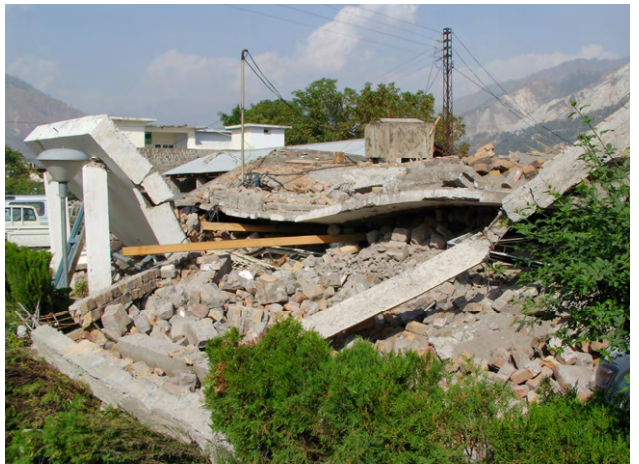
農業省建物の倒壊現場
