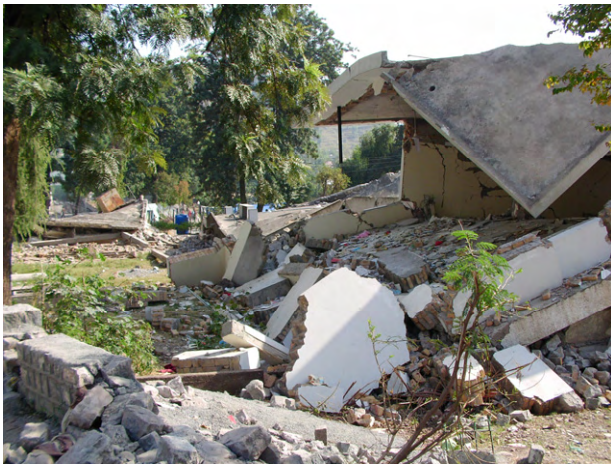
ムザファラバード図書館の倒壊現場
