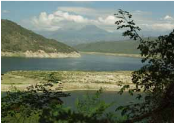
サバナ・イエグア・ダム の現況 (水位が低下した状況)
