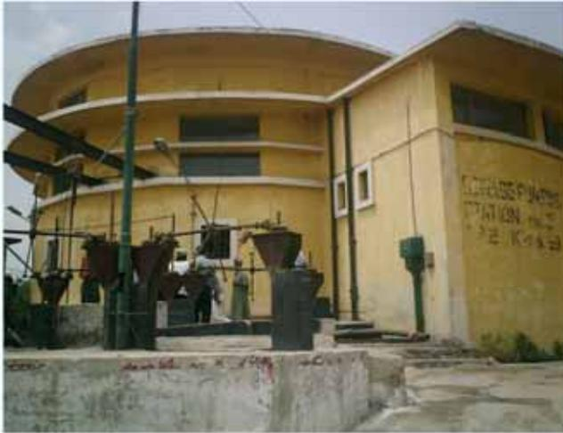
第3下水処理場に送水するClifton 汚水中継ポンプ場流入部のゲート、スクリーン等の状況
