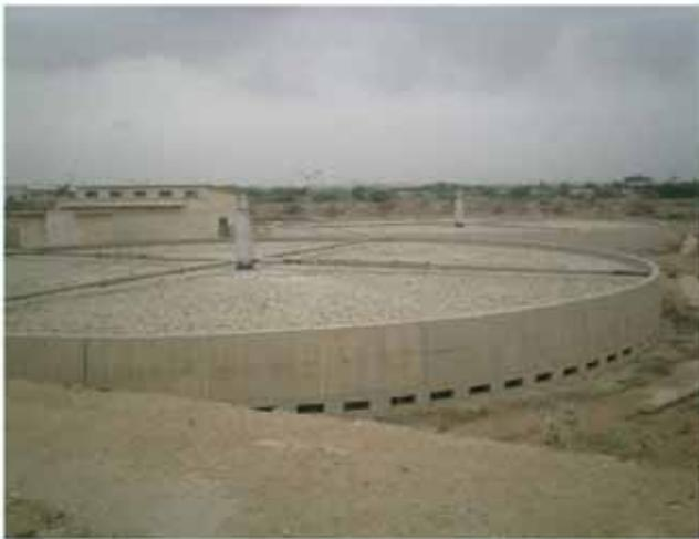
第1下水処理場の一部高速散水濾床は現在運転を中止
