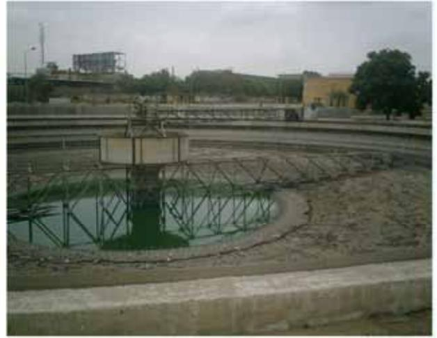
第1下水処理場は流入汚水不足のため、一部の最初沈殿池は現在運転を中止している
