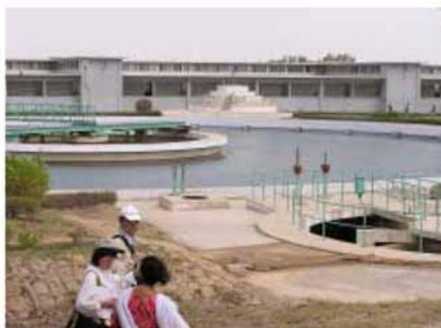
COD 浄水場のアクセレータ式沈殿池
