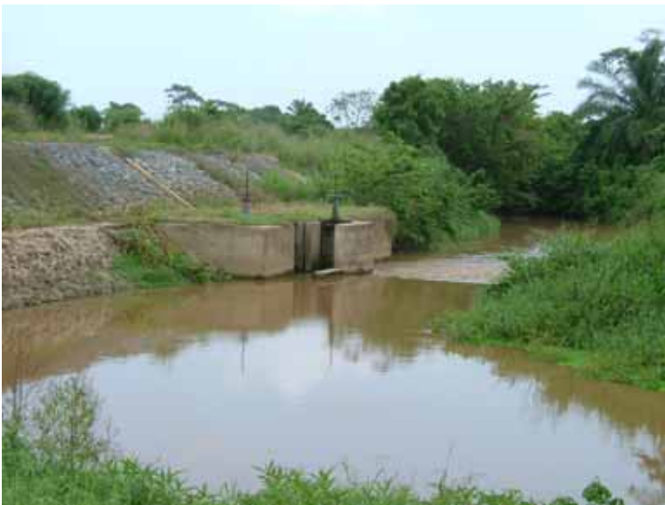
オチェレコ灌漑地区 ポンプ場へ導水するための堰
