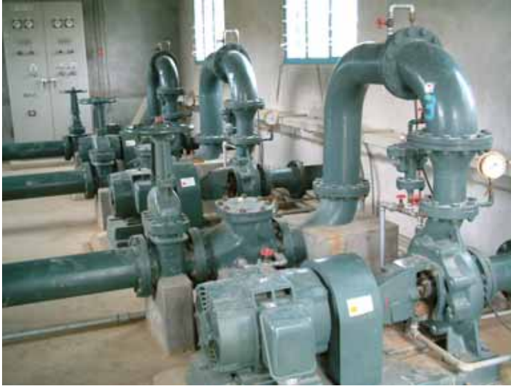
オチェレコ灌漑地区 ポンプ施設
