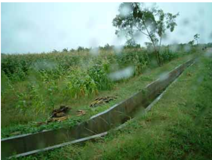
アシャマン灌漑地区 用水路
