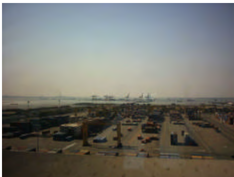
写真-11 コンテナヤード →オペレーションタワーから全体を監視する。ヤード上は警備員が巡回する。
