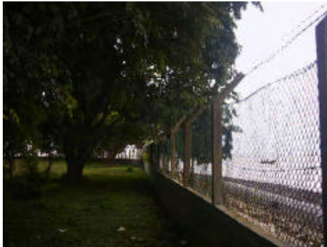
写真-17 Belawan 港フェンス →所々壊れている
