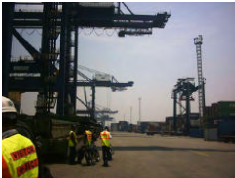
写真-1 JICT 照明設備 →50m 間隔で配置されている。
