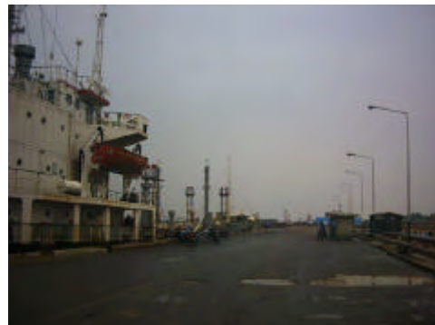
写真-20 Dumai 港栈橋上の照明設備
