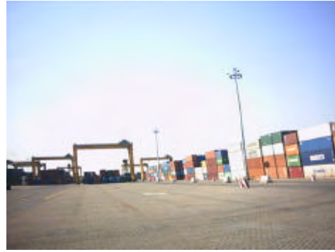
写真-8 Tg. Perak 港公共埠頭内 →照明が一定間隔で配置されていた。
