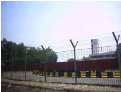
写真-3 JICT フェンス
