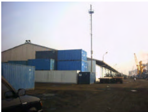
写真-5 港内照明設備 →故障も多く照度不十分
