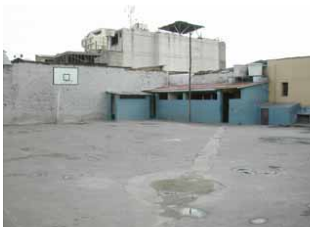
別棟のトイレ棟
