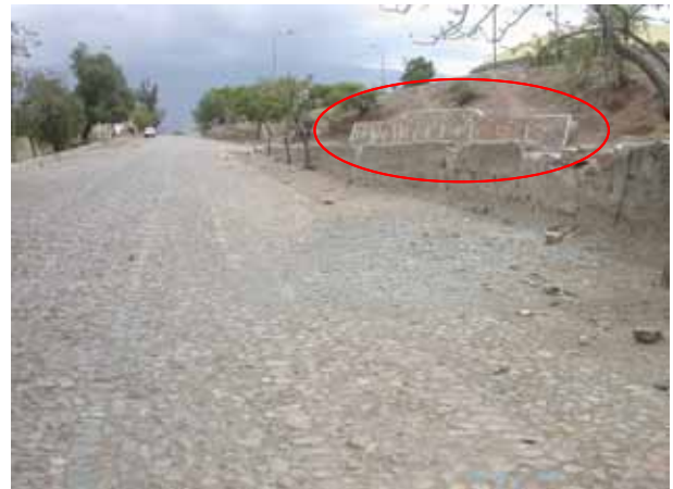
敷地内の擁壁
