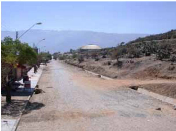
前面道路の状況
