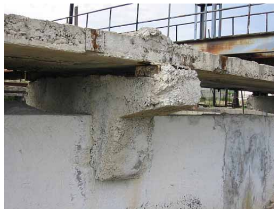
曝気槽移動式台車基礎コンクリート
