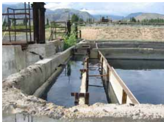
曝気槽外壁コンクリート
